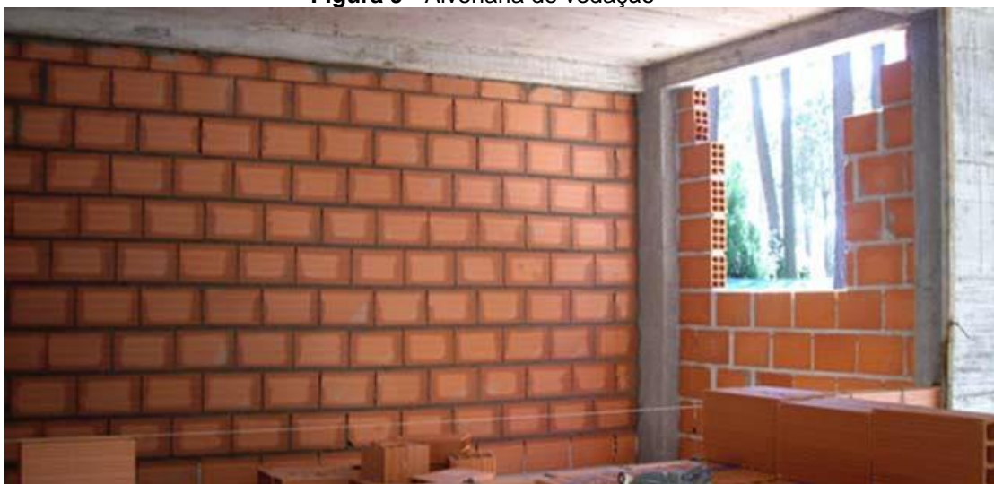
Figura 9 - Alvenaria de vedação
