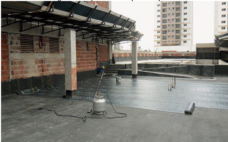
Figura 8 - Impermeabilização de lajes
